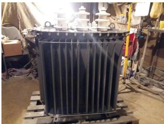
5.11-сурет - 6,3/0,4 кВ трансформаторлар
